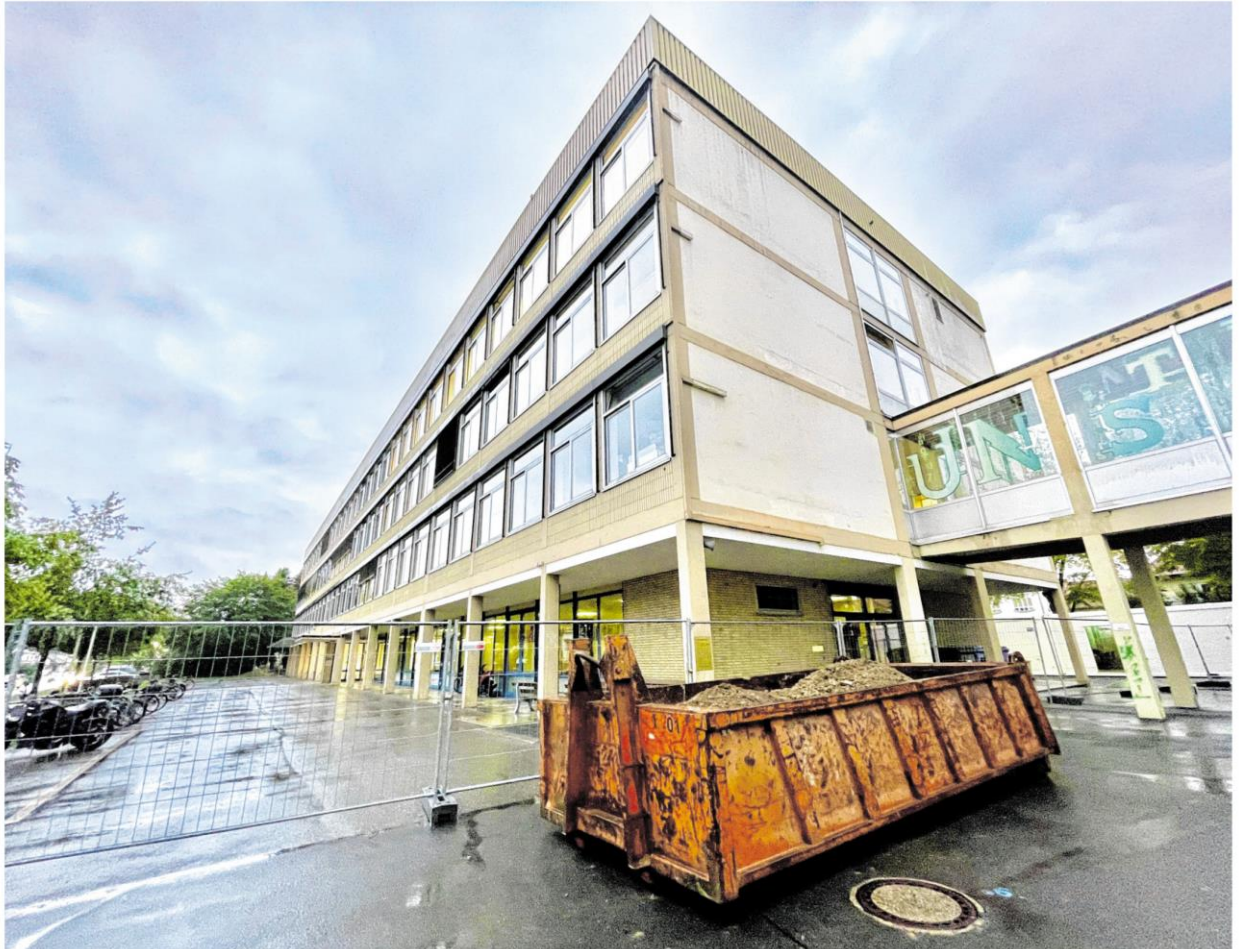
Den Zuschlag für die Dacharbeiten am Matthias-Grünwald-Gymnasium erteilte der Technische Ausschuss der Tauberbischofsheimer Firma Rudorfer.
